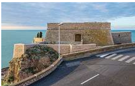
Vue depuis le nord.
